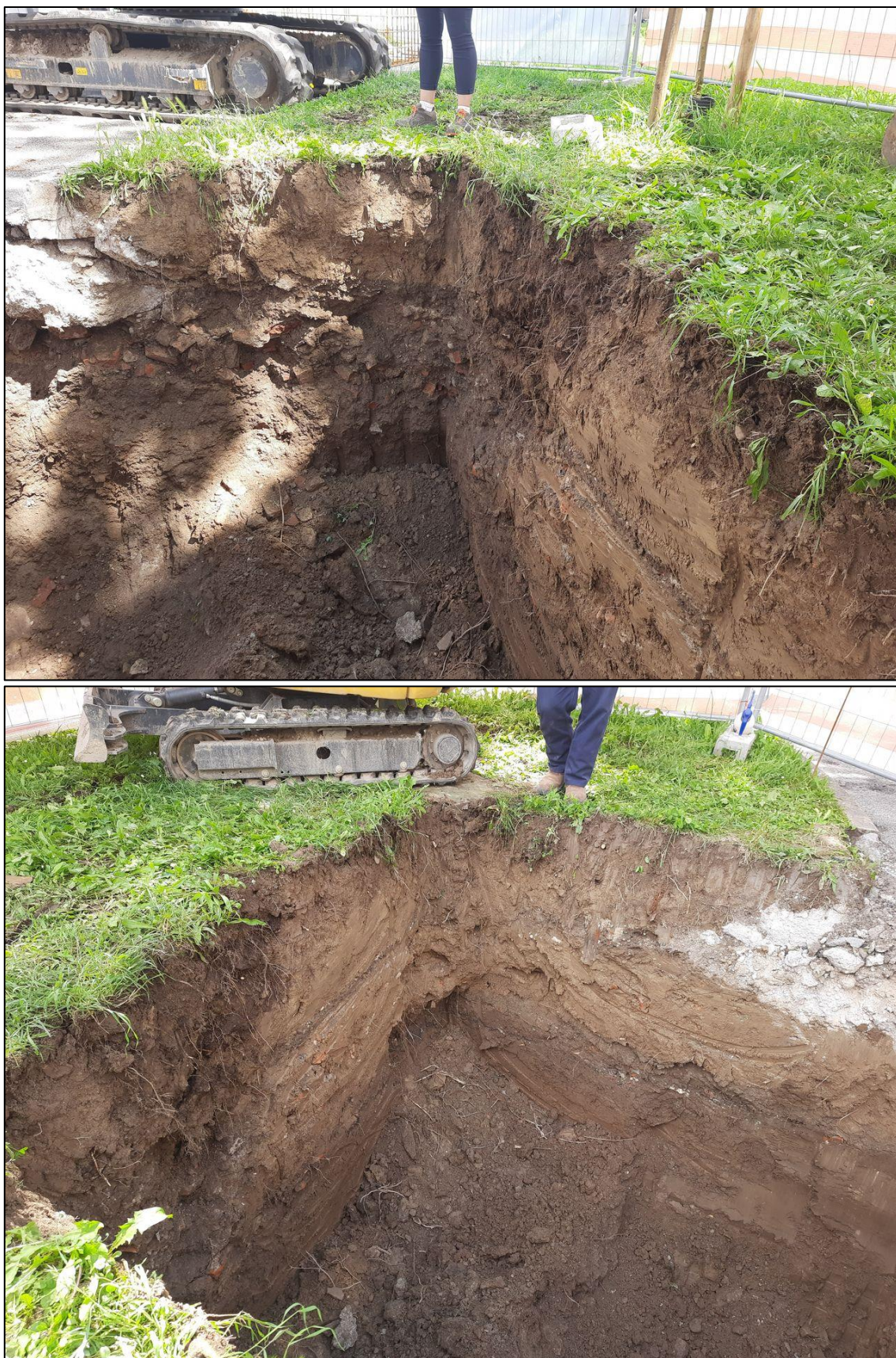
Figura 8: scavo ultimato – recisione delle radici e, a seguito, disinfezione delle stesse
